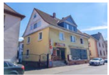
Breureberg/Sandbach , Wohn-/Geschäftshaus (2 Gewerbeeinheiten/6 Wohnungen), ca. 485 m 2 Wohn-/Nutzfläche, Dach 2007 neu eingedeckt, Bäder 2015 neu gestaltet, Scheune, 625 m 2 Grdst. Energieausweis in Bearbeitung!
